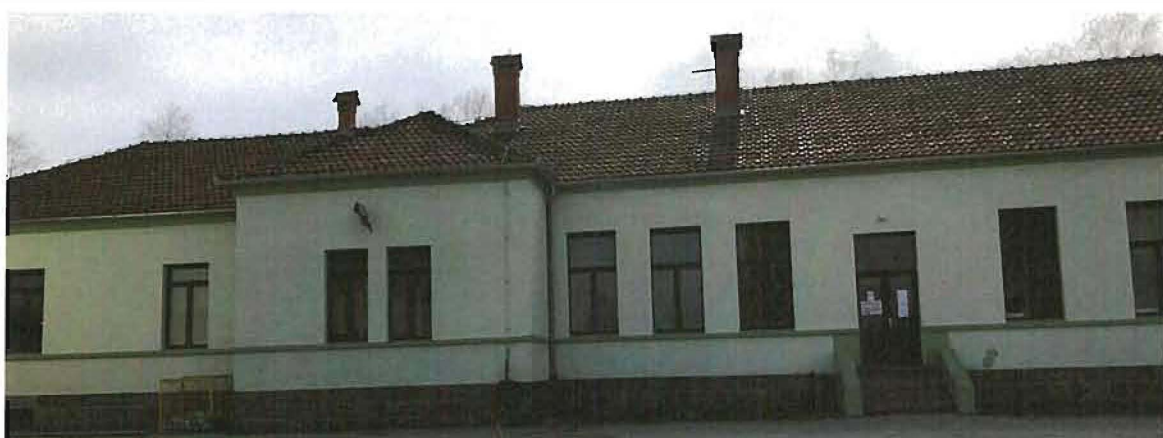
Фотографије фасада објекта бр. 1 – стара школа
