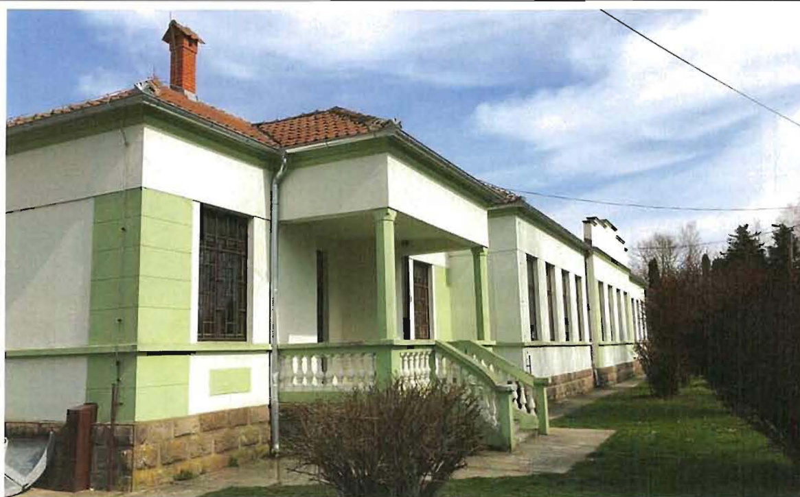
Фотографије фасада објекта бр. 1 – стара школа
