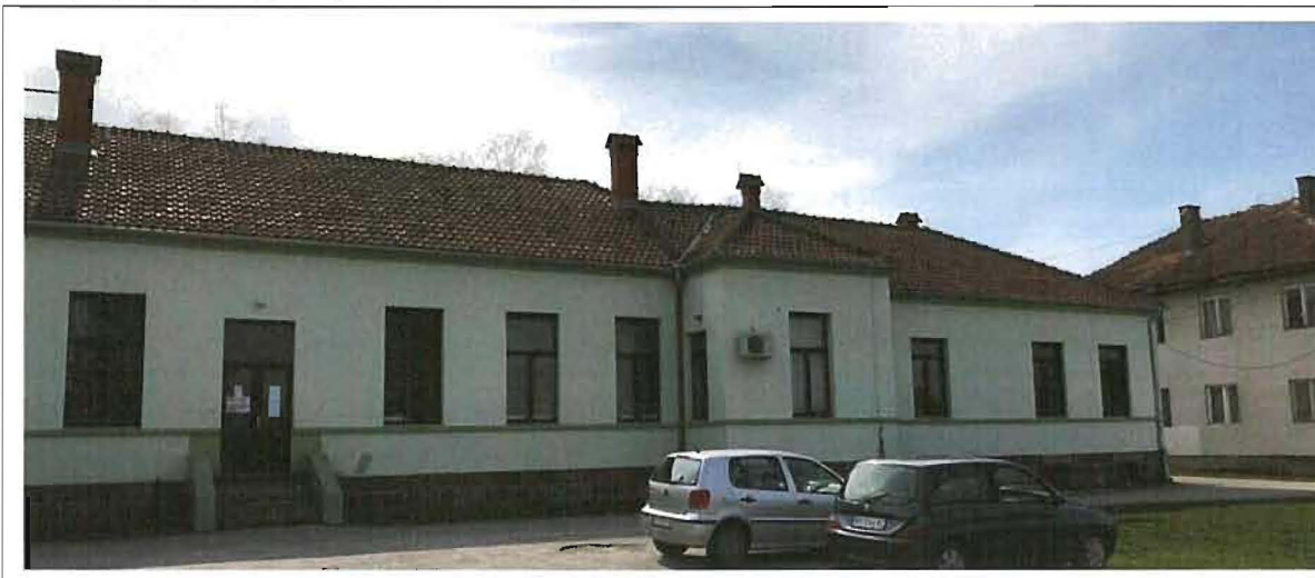
Фотографије фасада објекта бр. 1 – стара школа
