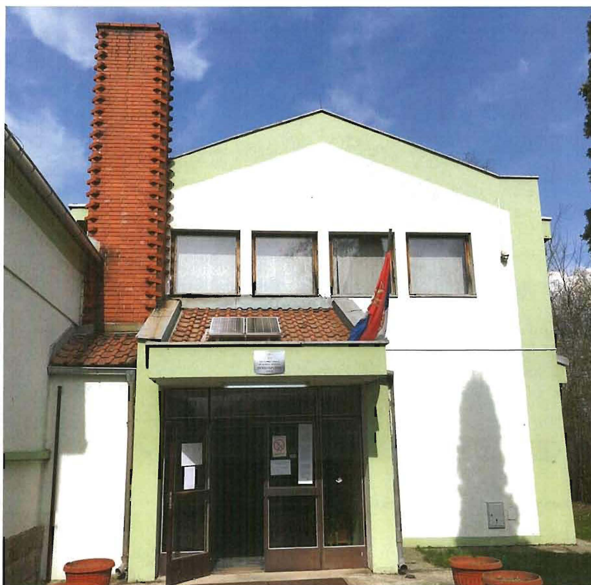
Фотографије фасада објекта бр. 4 – нова школа
