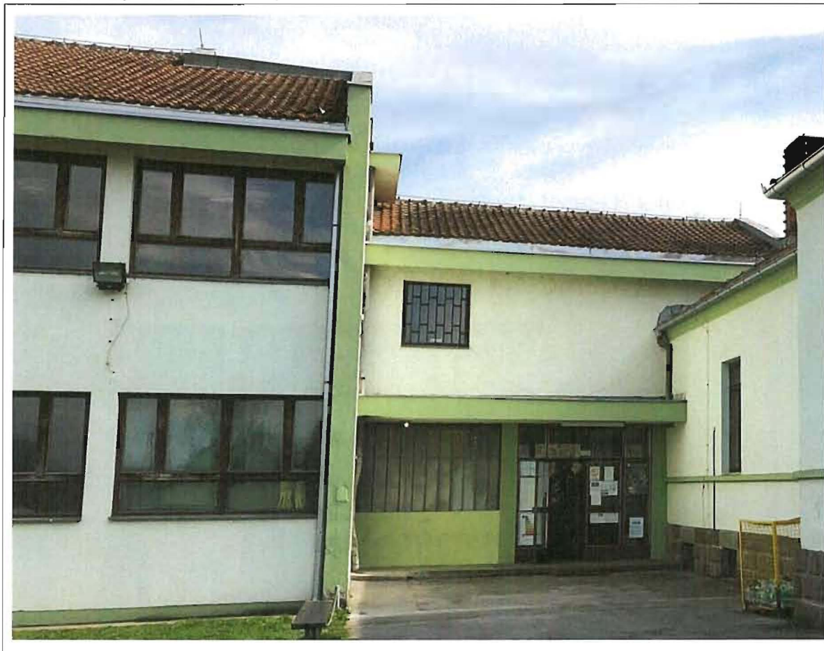
Фотографије фасада објекта бр. 4 – нова школа
